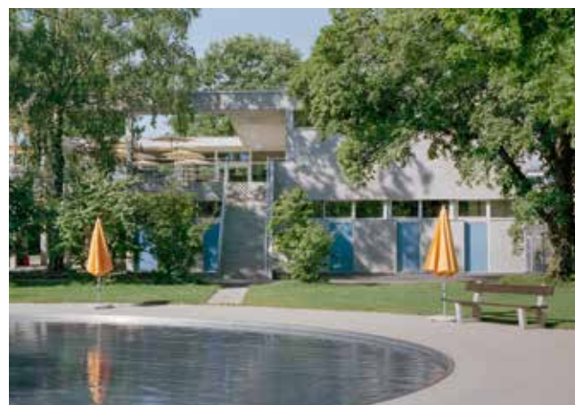
3 Die äussere Betonhülle ist wieder gemäss der ursprünglichen Erscheinung hergestellt.
