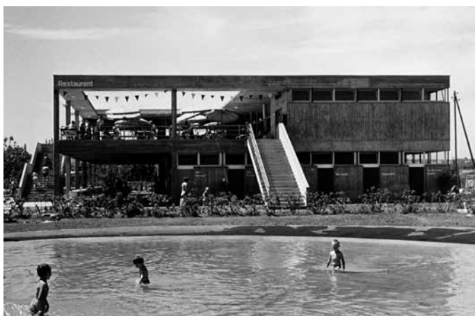
2 Der Bestandsbau von 1962 der Architekten Otto und Walter Senn und des Ingenieurs Heinz Hossdorf nach seiner Eröffnung.
